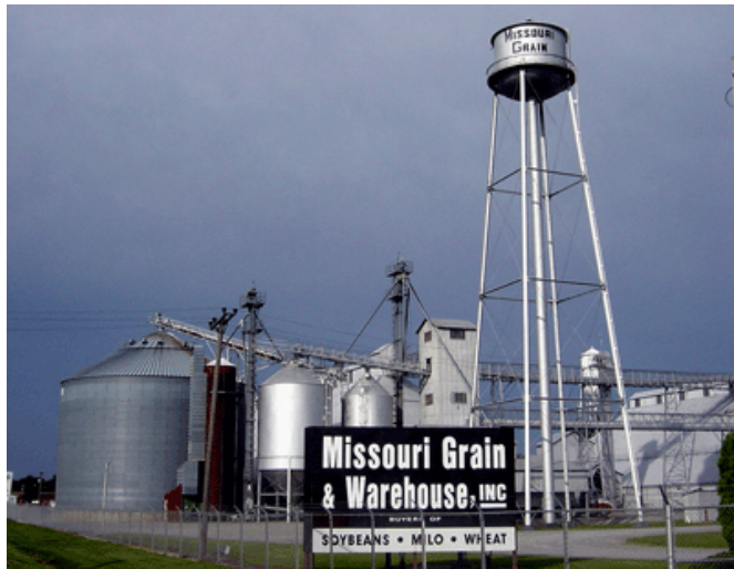
Hình 6.8. Kho Silo (Kho máy) chứa hạt
